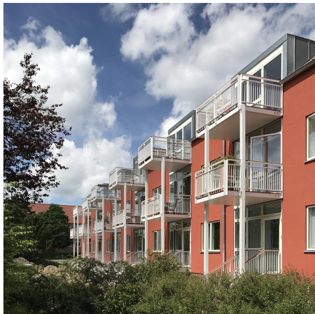
(Energi)reovering Toftebo, Bjerg Arkitektur
