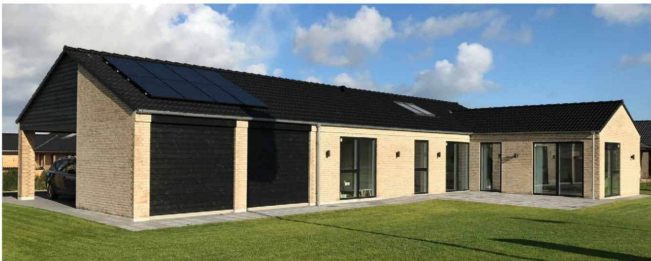
Typisk typehus opført til lavenergiklasse 2015.
